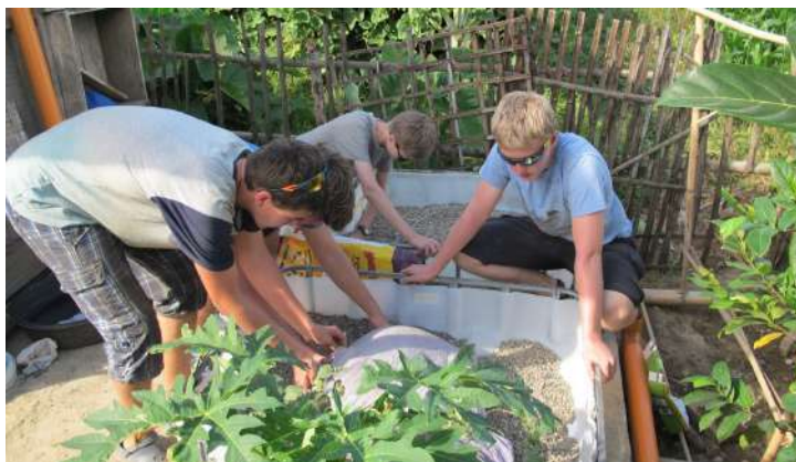
Speiderne bygger en vanntank der man dyrker grønnsaker over en tank med fisk. Plantene får vann fra fiskedammen og fisken får næring fra plantene.
